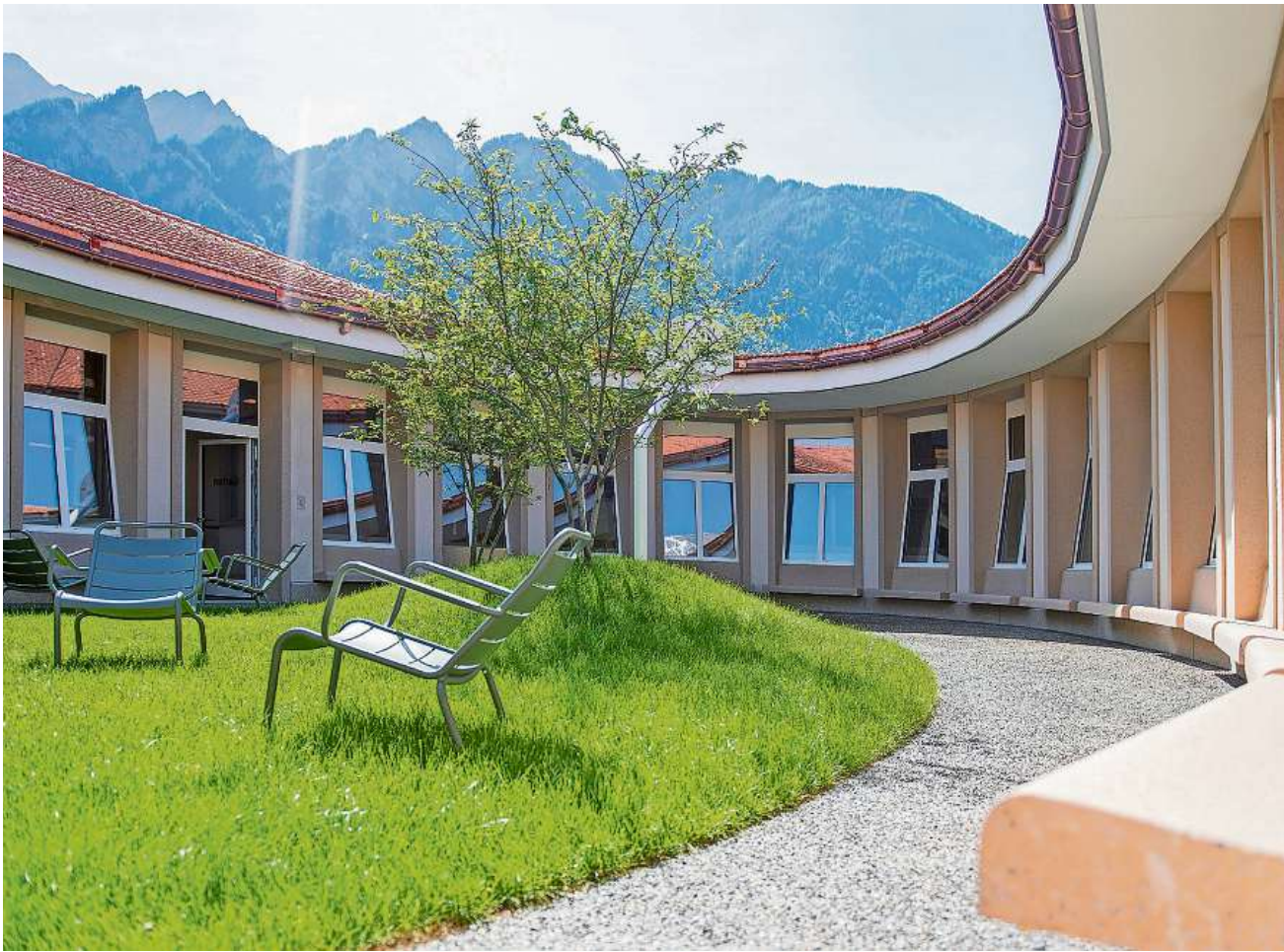
Ausgeklügelte Dachkonstruktion: Herzstück des geschlossenen Bereichs der neu gebauten psychiatrischen Notfallstation ist der begrünte Innenbereich.
